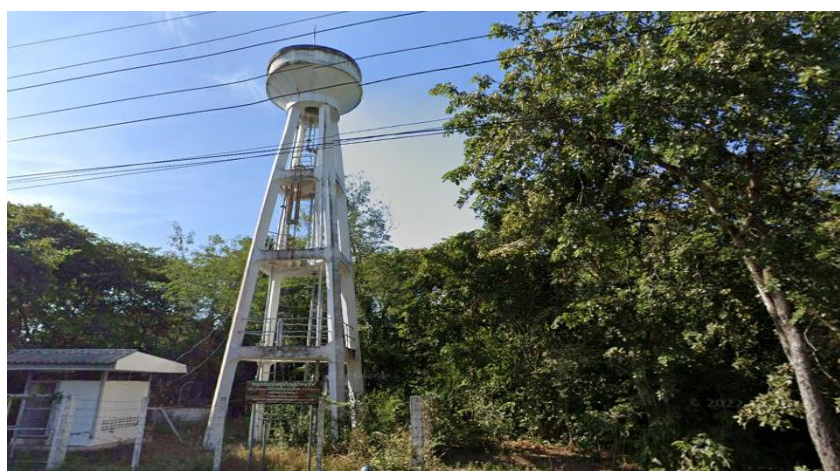
ระบบประปาบาดาล หมู่ที่ 7 บ้านนาโน ตำบลหนองน้ำใส อำเภอบ้านไผ่ จังหวัดขอนแก่น
