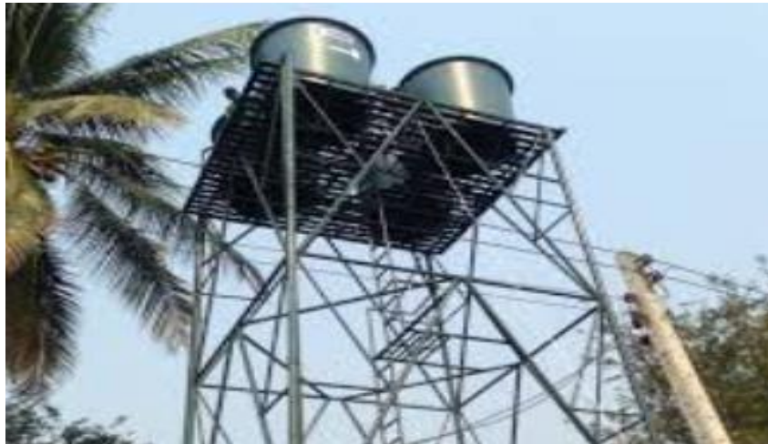
ระบบประปาบาดาล หมู่ที่ 9 บ้าน กม.16 ตำบลหนองน้ำใส อำเภอบ้านไผ่ จังหวัดขอนแก่น
