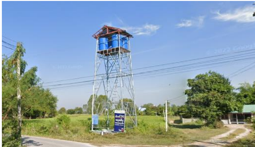
ระบบประปาบาดาล หมู่ที่ 5 บ้านเก่าหัวนา ตำบลหนองน้ำใส อำเภอบ้านไผ่ จังหวัดขอนแก่น
