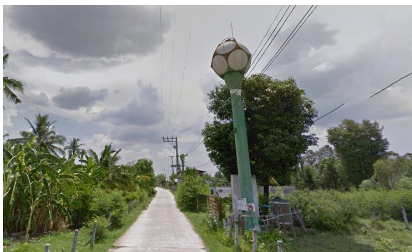
ระบบประปาบาดาล หมู่ที่ 11 บ้านโนนสวรรค์ ตำบลหนองน้ำใส อำเภอบ้านไผ่ จังหวัดขอนแก่น
